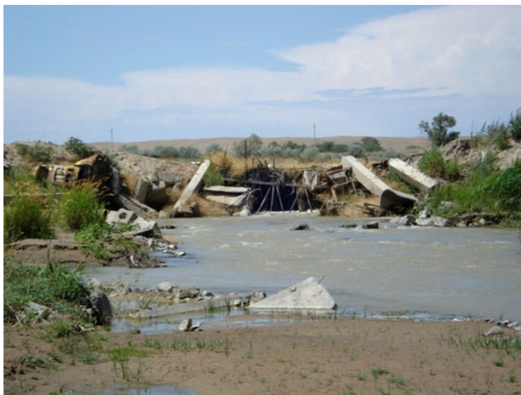
Рисунок 4. Самодельная плотина на предгорном участке р.Каскелен для поднятия уровня воды и последующего распределения ее по полям. Как и во всех остальных случаях, никаких рыбозащитных устройств нет. Однако данная плотина выполняет и положительную роль: препятствует расселению чужеродных видов вверх по реке.
