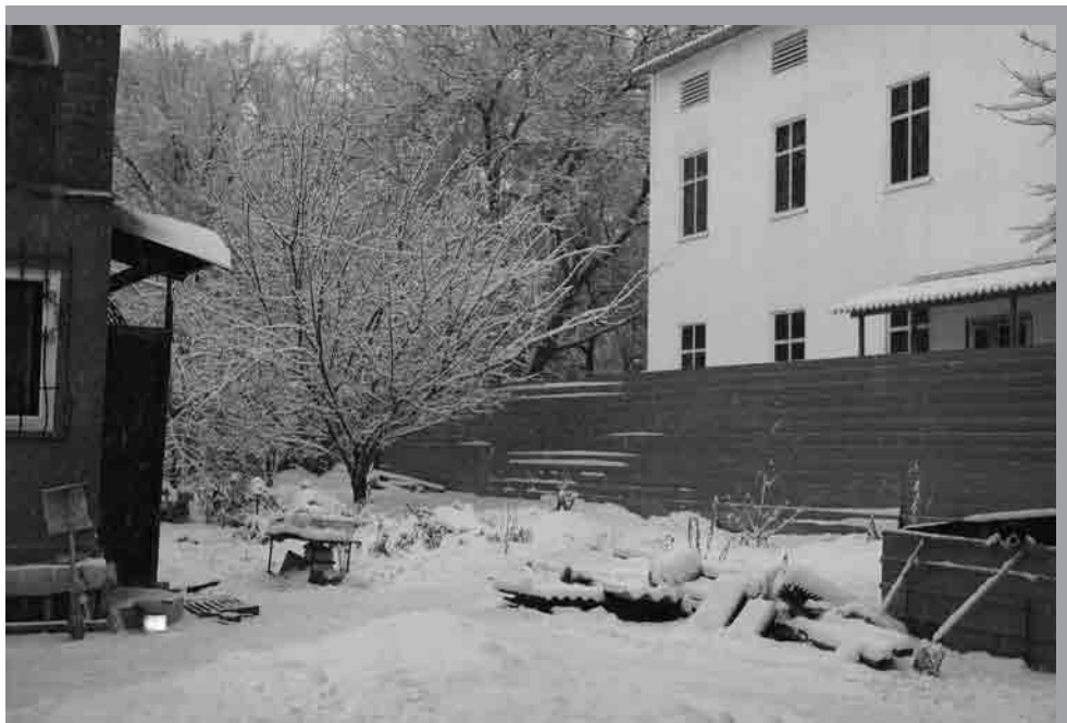
Строительство ветеринарной лаборатории завершено. Справа – здание лаборатории, слева – жилой дом. Санитарно-защитная зона отсутствует. Фото 2010 года.
