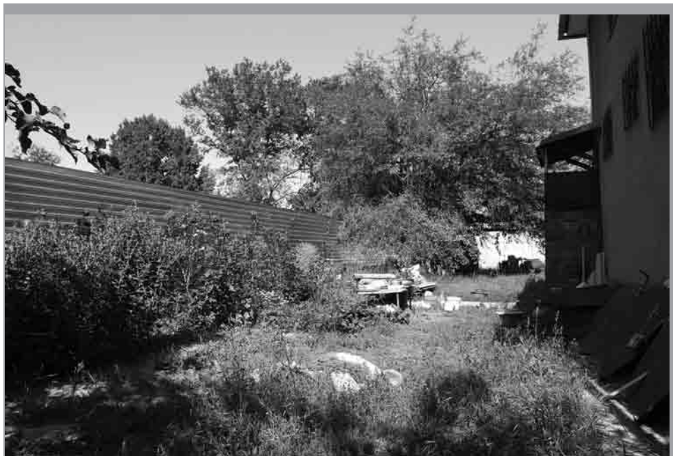
Начало строительства ветеринарной лаборатории. Жилые дома расположены в непосредственной близости от опасного объекта. Фото 2009 года.
