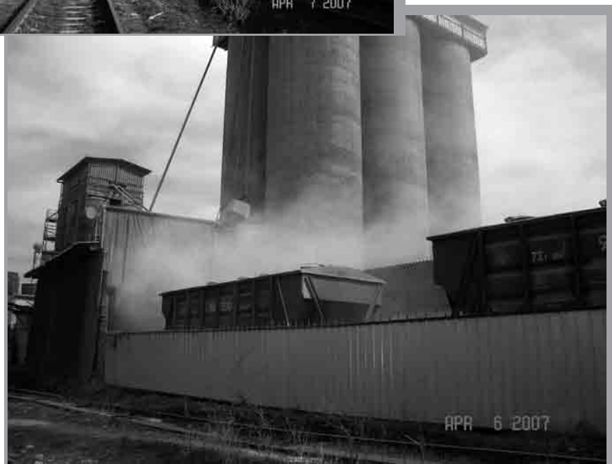
Разгрузка цемента на КСМК-3. Фото 2007 года.
