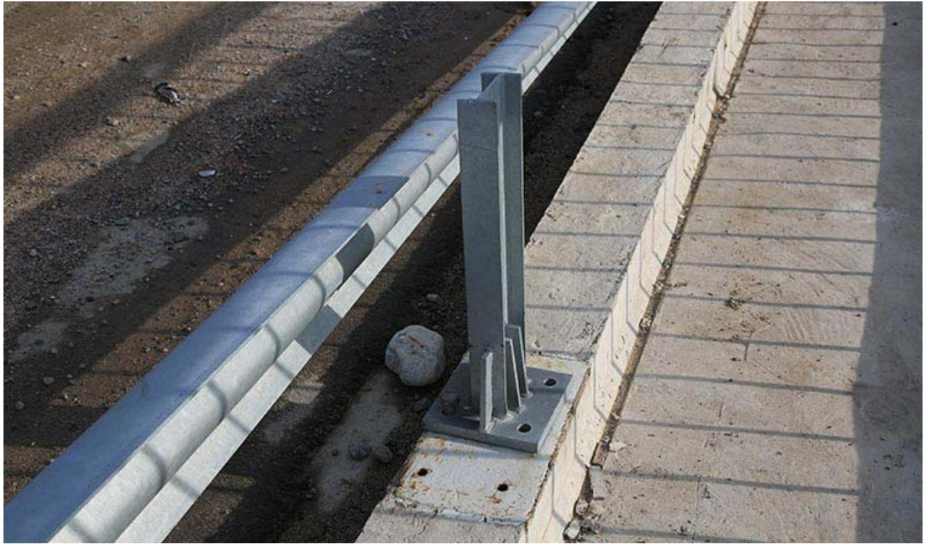
**Фото 23. Мост. Ограждение проезжей части, разобранное местными жителями.
