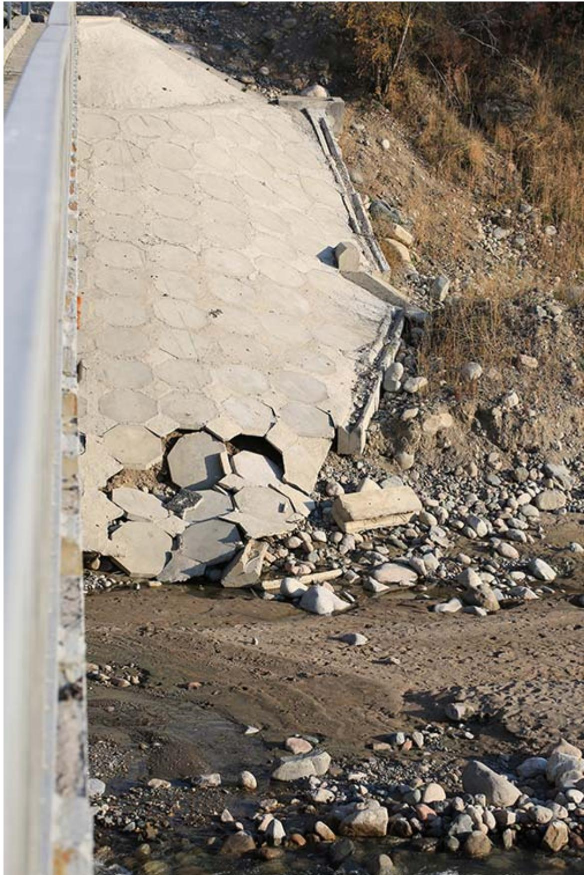
Фото 21. Конус (откос) моста, разрушенный водой. Восточный берег.
