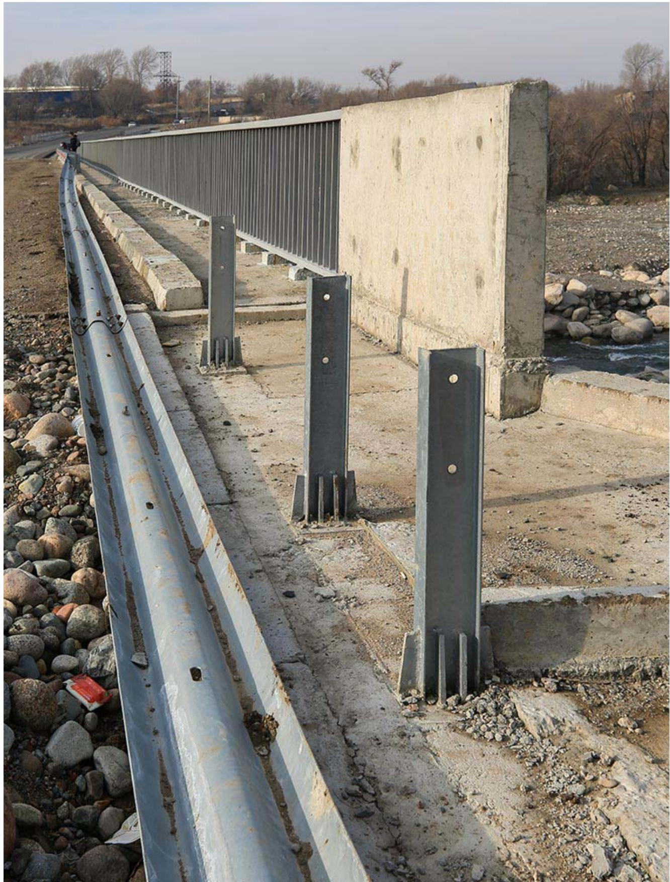
**Фото 22. Мост. Ограждение проезжей части, разобранное местными жителями.**
