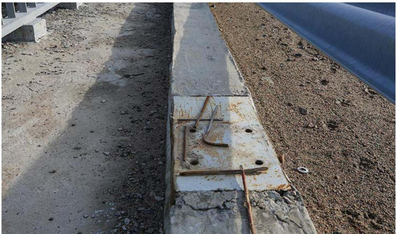
**Фото 24. Мост. Ограждение проезжей части, разобранное местными жителями.
