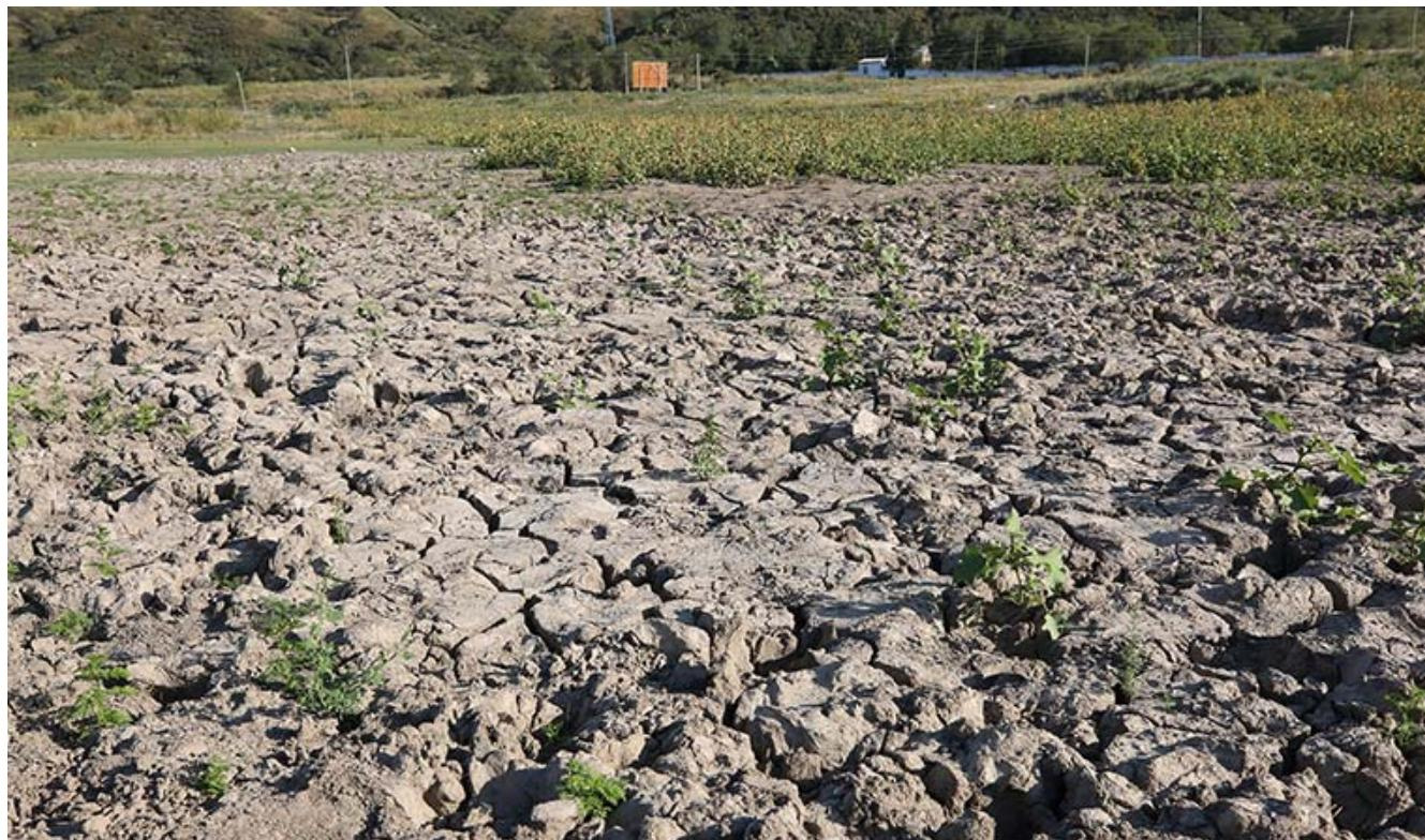
**Фото 80. Высохшая лужа на поверхности засыпанной выемки.
